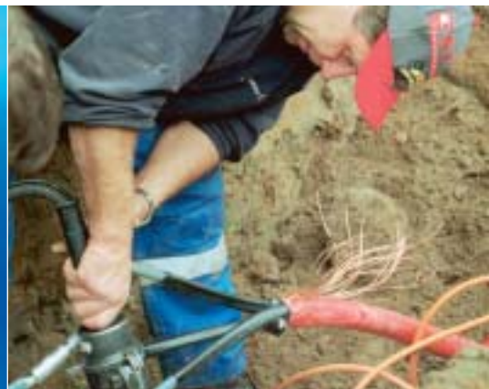
Skarvning av en jordkabel i Svenljunga.
