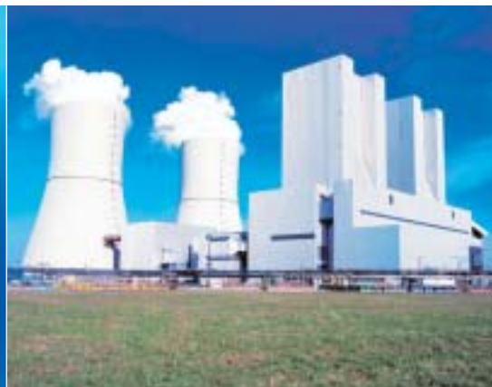
Värme kraftverket Lippendorf.
