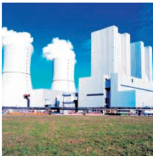
Värmekraftverket Lippendorf, Tyskland.
