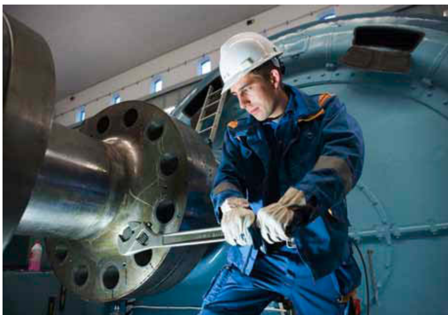
Underhållsarbete vid Älvkarleby vattenkraftverk.
