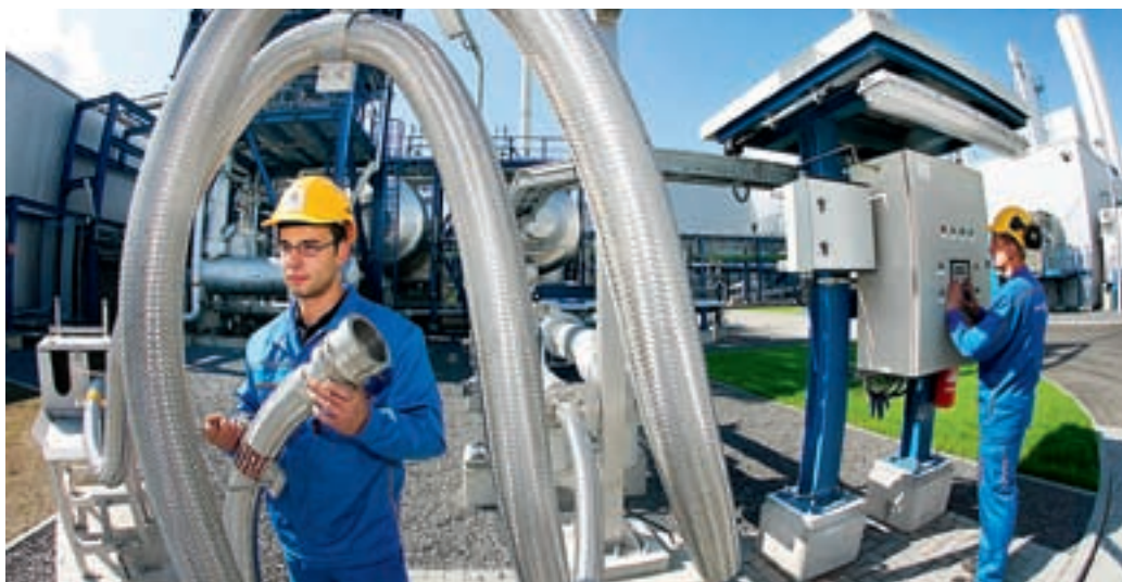
Pilotanläggningen för CCS vid Schwarze Pumpe.
