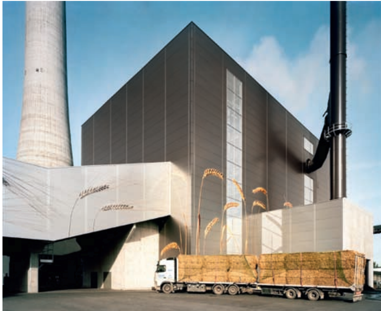
Fynsværket i Danmark
