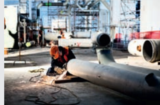
Rörsvetsarbete vid kraftvärmeverket Moorburg i Hamburg, Tyskland.
