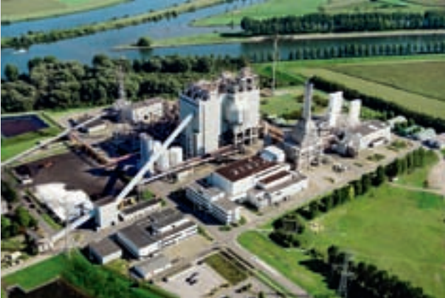
Kraftverket Willem Alexander i Buggenum, Nederländerna.
